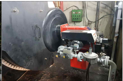
LNG 보일러 전환
