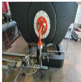
LNG 보일러 전환
