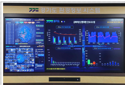
CCTV 점검 상황판
