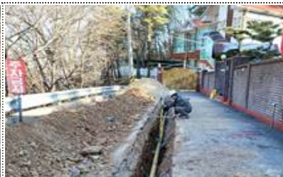
도시가스 배관망 설치
